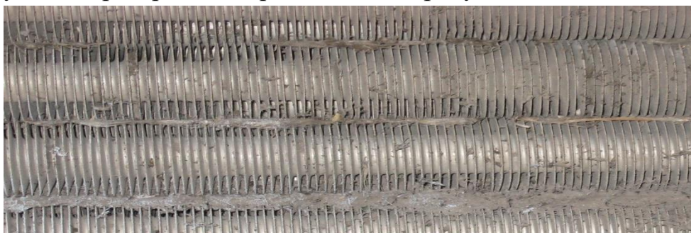
Рисунок 1 – АВО газа с органическими загрязнениями оребренного межтрубного пространства
